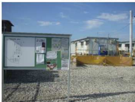
益城町櫛島仮設団地
